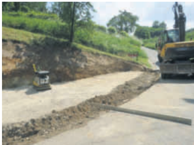
Herstellung eines Parkplatzes am Schlossberg
