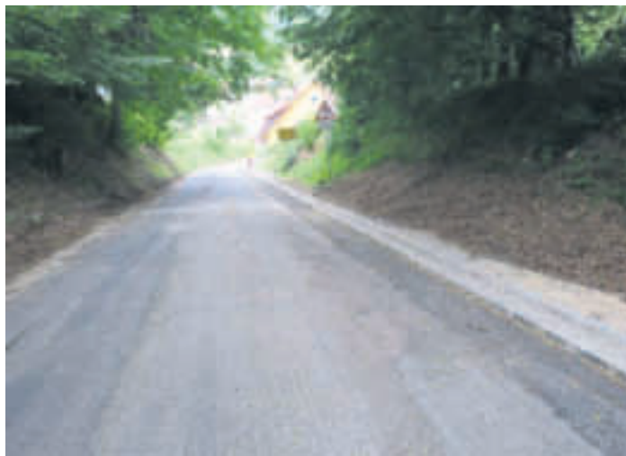
Teearbeiten Berg zwischen Zeubach und Hannberg
