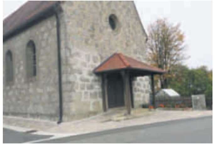
Pflasterarbeiten im Kirchemumfeld Hubenberg
