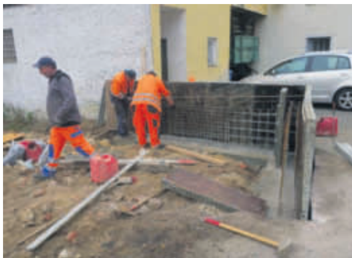
Bau der Mauer am Auberg
