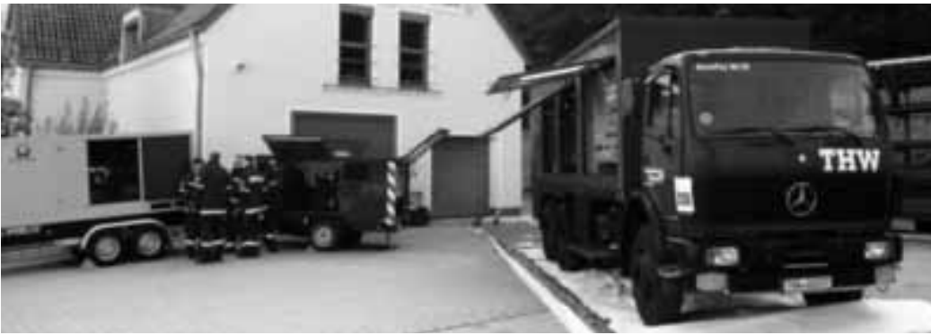
Das 2014 angeschaffte Notstromaggregat der Juragruppe und das große Notstromaggregat des Technischen Hilfswerkes Pegnitz stellen die Wasserversorgung im Falle eines großflächigen Stromausfalls oder einer Katastrophe sicher.
