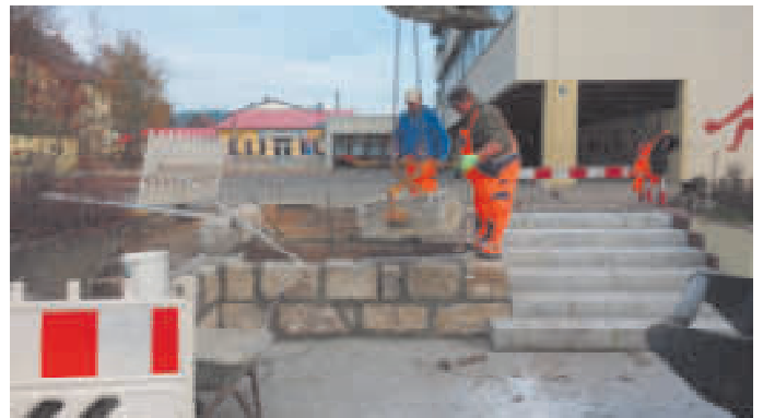
Neuanlage Treppenaufgang Schule
