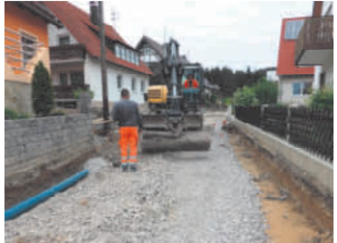
Umfassende Sanierung Mönchsgrundstraße
