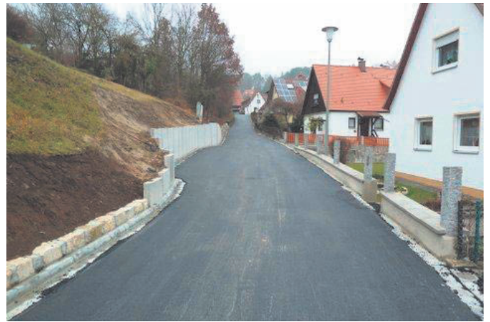
Ausbau der Dürrgrundstraße
