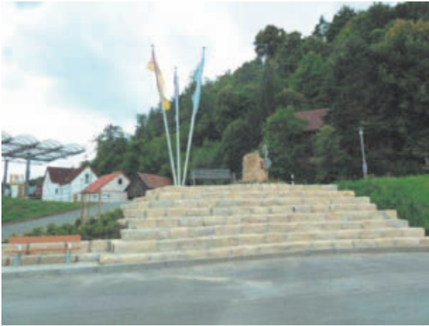
Errichtung einer Steintribüne am Sportplatz
