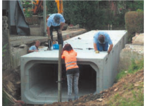
Brückenneubau in Löhlitz durch Einbau eines größeren Durchflusses aus Betonhohlkastenprofilen
