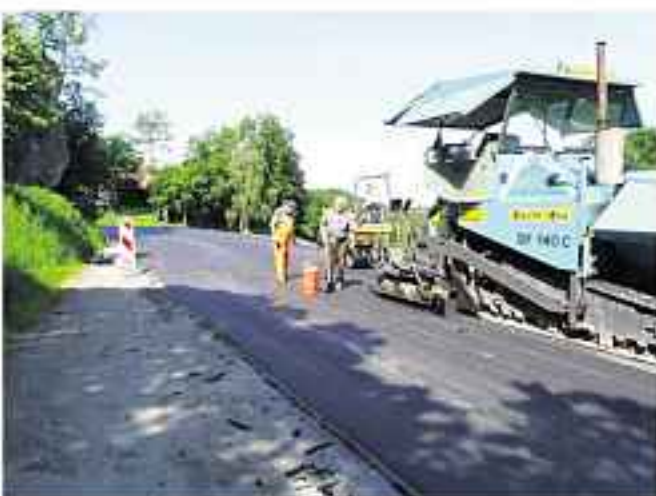
Kurvenbegradigung Ortseingang Köttweinsdorf
