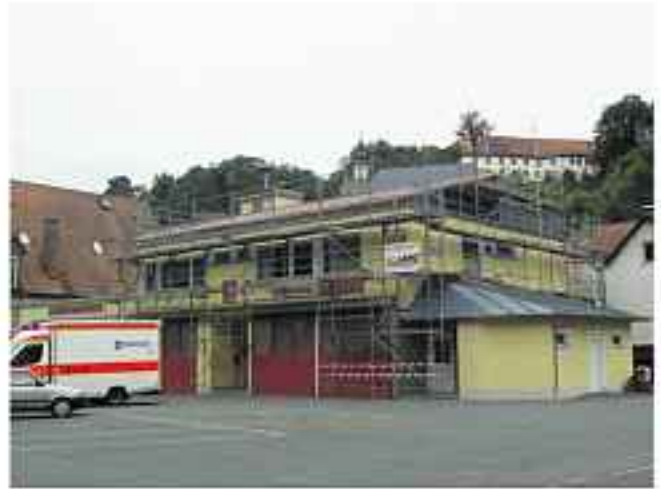
Sanierung Dach Mehrzweckhaus
