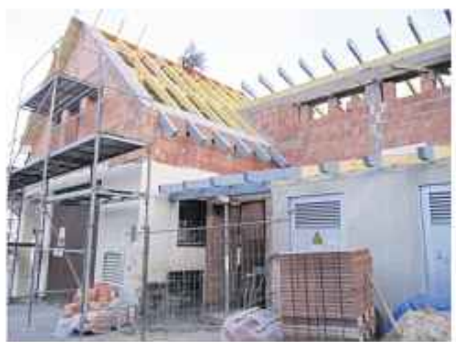
Anbau Feuerwehrhaus Löhlitz
