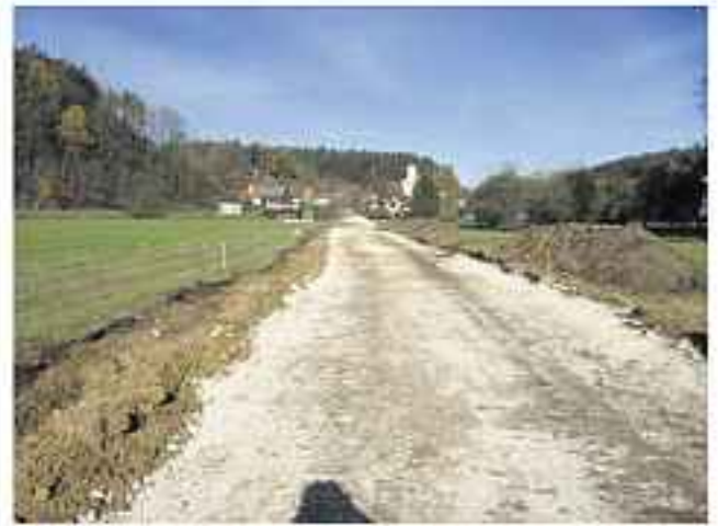
Baubeginn Radweg Nankendorf – W'feld
