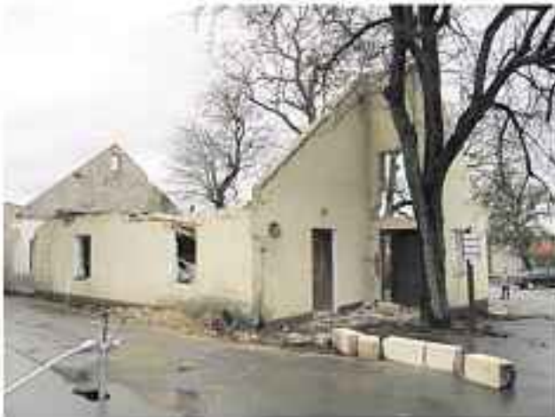
Abbruch Haus der Bäuerin in Breitenlesau
